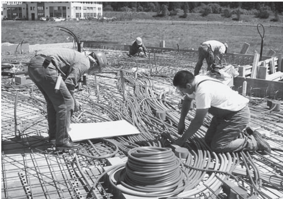
Tägliche Arbeit der Elektromonteur: Das Verlegen der elektrischen Leitungen auf der Baustelle eines Zweifamilienhauses.
